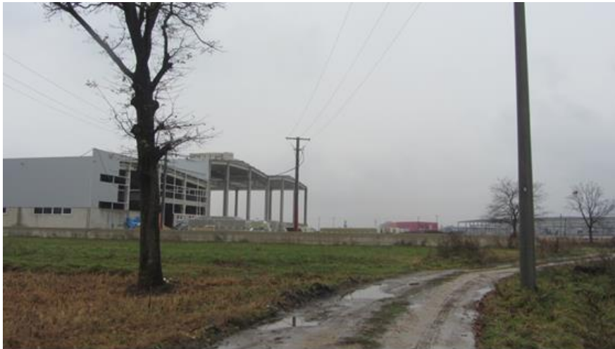
Slika 2. Oštećenje pristupnog puta poslovnoj zoni otežalo je poslovanje rezidentnih preduzeća koja su isto tako bila u velikoj opasnosti od poplava
